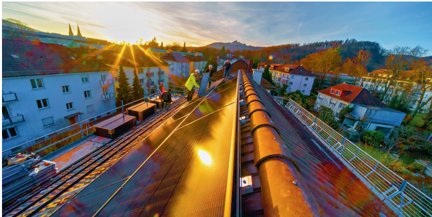
Die Arbeiten auf dem Dach des Generationenhauses in Olten gehen bei unserem Besuch an einem Samstag im Februar mit wenigen Abstimmungsproblemen gut voran – wenige Tage danach steht die Anlage.
