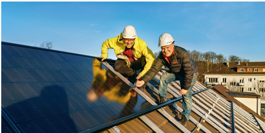
Ein Gemeinschaftswerk von Miteigentümer Tobias Oetiker (in gelber Jacke) und Solarprofi Martin Blapp (Bauleiter) sowie Familie und Genossenschaft. Pizzen und ausführliche Berechnungen der Kabellängen gehören dazu.
